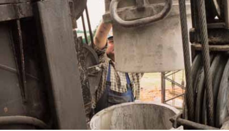
Aufsetzen des Rohrverschlusses für die Fußausrammung
